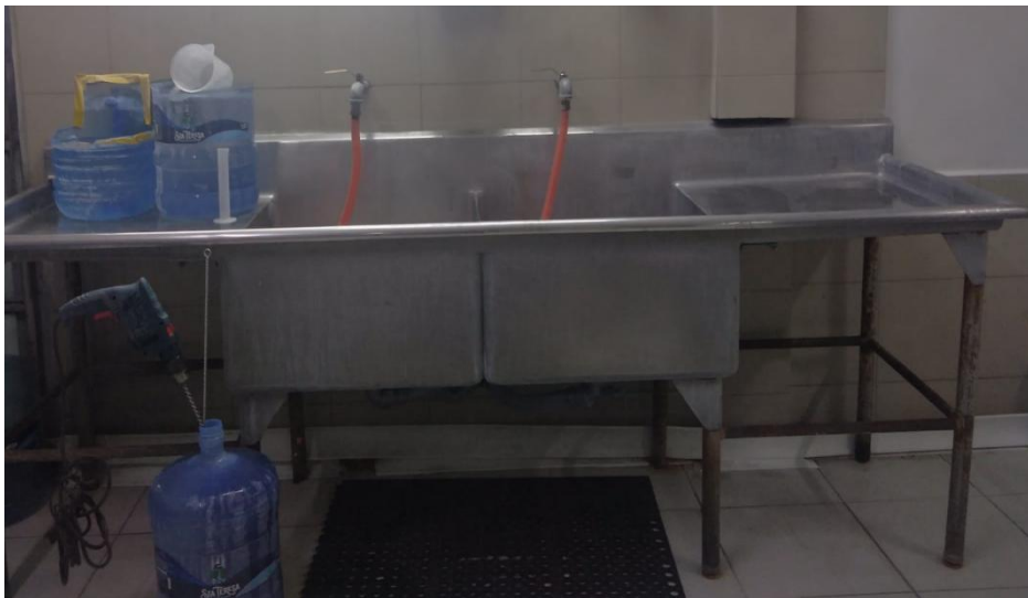
Ilustración 3. Área de lavado.
